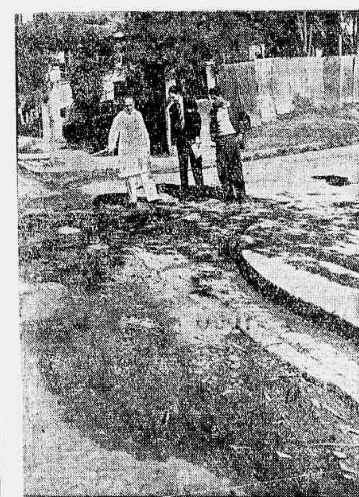
Um aspecto da rua Xavier dos Passaros, cujos trabalhos de calçamento serão iniciados dentro em breve
