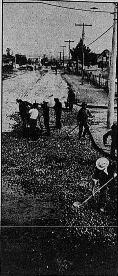
Quase 80 quarteirões do Capão da Imbuá estão recebendo melhorias que beneficiarão 7 mil pessoas.
