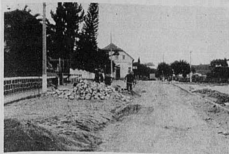
As ruas centrais de Indaial estão recebendo calçamento.
