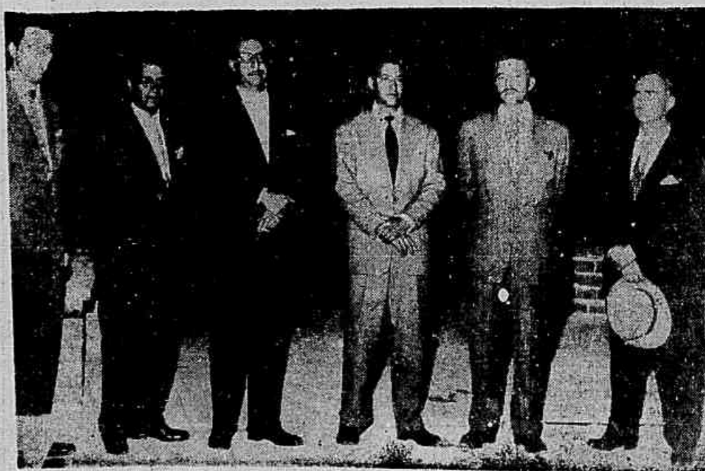
Durante sua permanência nesta Capital onde veio assistir à inauguração da nova sede do I.A.P.I., o sr. José Raymundo Soares, presidente dessa Autarquia visitou as obras do Super Mercado Municipal. S.S. que é experimentado administrador, tendo sido Prefeito de progressistas cidades mineiras durante 10 anos, devendo candidatar-se nas próximas eleições à Prefeitura de Belo Horizonte, quis se inteirar de todos os pormenores da realização do Super Mercado, não restando aplausos pela sua inteligente pianificação, estratégia de situação, funcionalidade e grandiosidade da obra, tendo mesmo afirmado: «A solução para o problema de abastecimento de Curitiba, através do Super Mercado, parece-me a mais eficiente, prática, simples e feliz que se poderia encontrar. Deveria ser generalizada para sua aplicação nas diversas cidades brasileiras de população equivalente a de Curitiba. Demonstra, principalmente, na foto, o visitante acompanhado do sr. Leonel Fraão Martins, delegado do IAPI no Paraná, titulares de Gestão Câmara & Cia. Ltda, realizadores do Super Mercado e representantes da imprensa.
