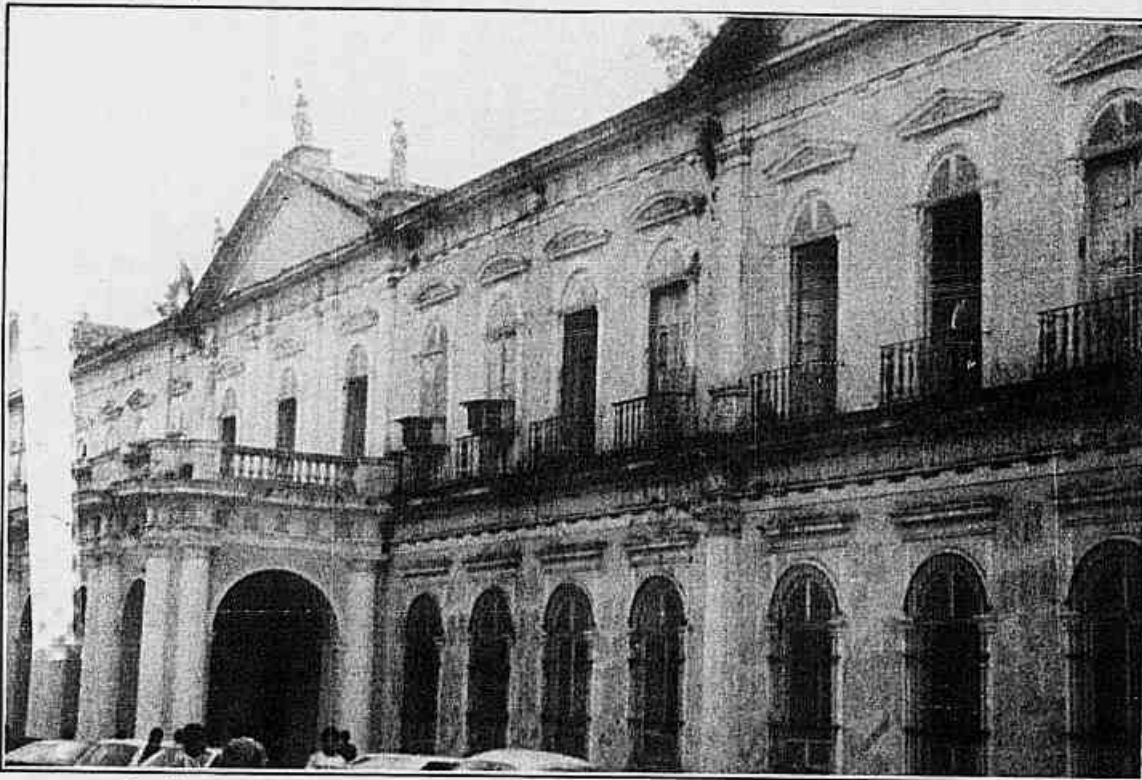
O antigo Palácio Antônio Lemos foi, aos poucos, sendo descaracterizado. Hoje, passa por obras
