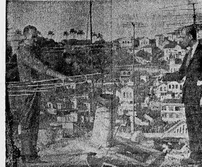
Tijolos e blocos de concreto voaram pelos ares, causando o pânico na redondeza. Um dos moradores do edifício e o repórter examinam os estragos.
