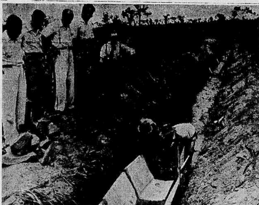
O Dr. Mario Pinotti, diretor e chefe do Serviço Nacional da Malária, quando assistia, acompanhado de sanitaristas daquele Serviço e do representante de A NOITE a colocação de uma calha num dos coletores de drenagem ainda em construção na região Gávea-Jacarepaguá. Várias centenas desses coletores formam uma intrincada rede de drenagem em todo o Distrito Federal.
