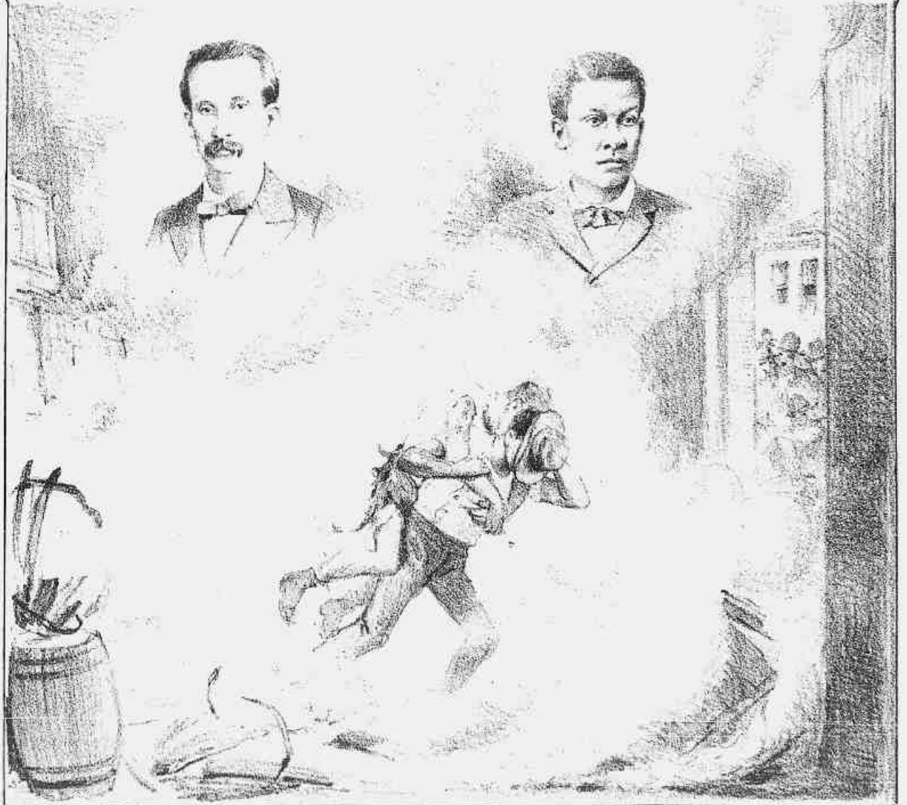
Jose Dias Caiado, administrador do trapiche Modesto, a casa empilhada no trapiche Incendio do trapiche Lazareto, na rua da Gambôa, no dia 22, as 6 horas da tarde O corajoso trabalhador Modesto, com risco de vida, arranca das chaminas o infeliz administrador.
