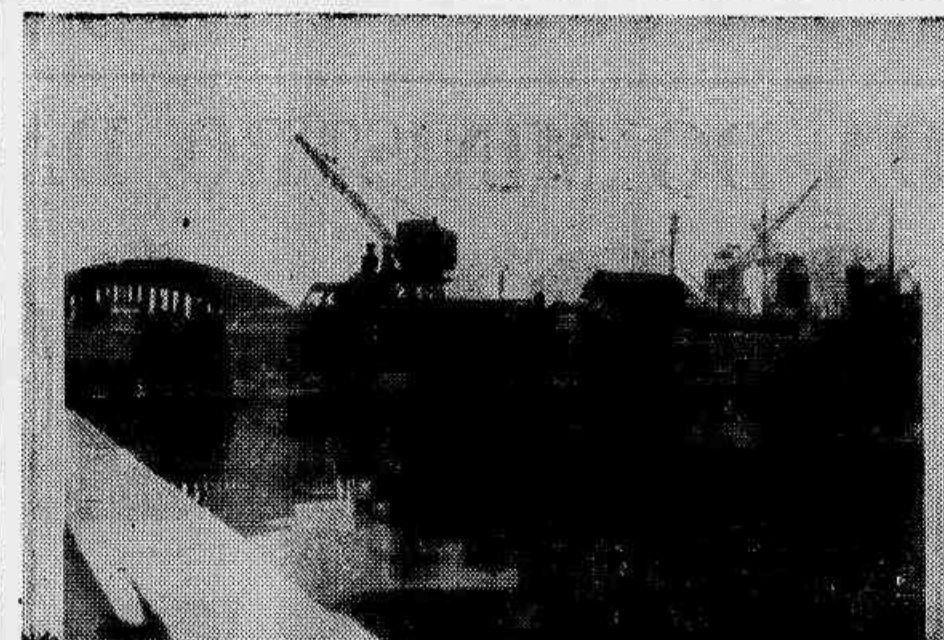
A PONTE DOS SUSPIROS — O prefeito Dulcideo Cardoso entregou, como prometera, ao tráfego, a Ponte dos Suspiros, inteiramente reformada, alargada de mais três metros e reforçada na sua estrutura. A ponte, que tem grande importância para o tráfego intenso da avenida Brasil, foi construída em 1903, na administração Pereira Passos. Esse melhoramento, concluído em tempo recorde, representa, sem dúvida, uma obra de real valor para a cidade. No clichê, vemos um aspecto da Ponte dos Suspiros, na sua nova fase.
