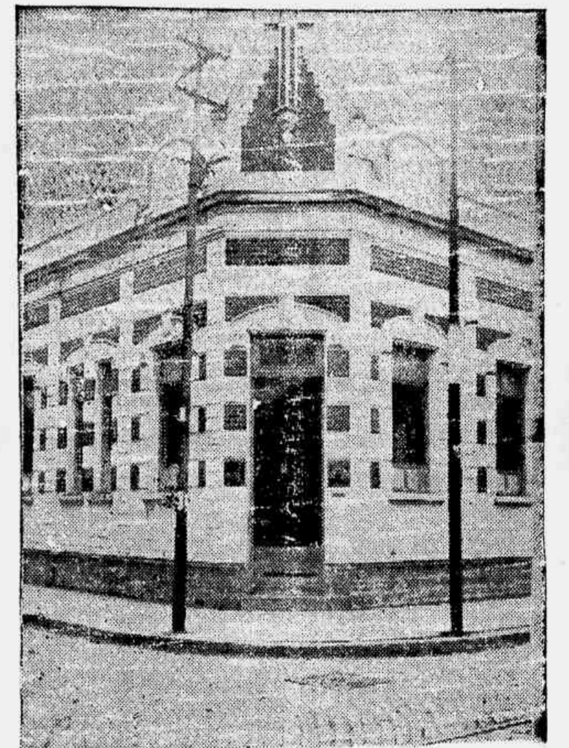
EDIFICIO DA BIBLIOTHECA MUNICIPAL DE NITHEROY
