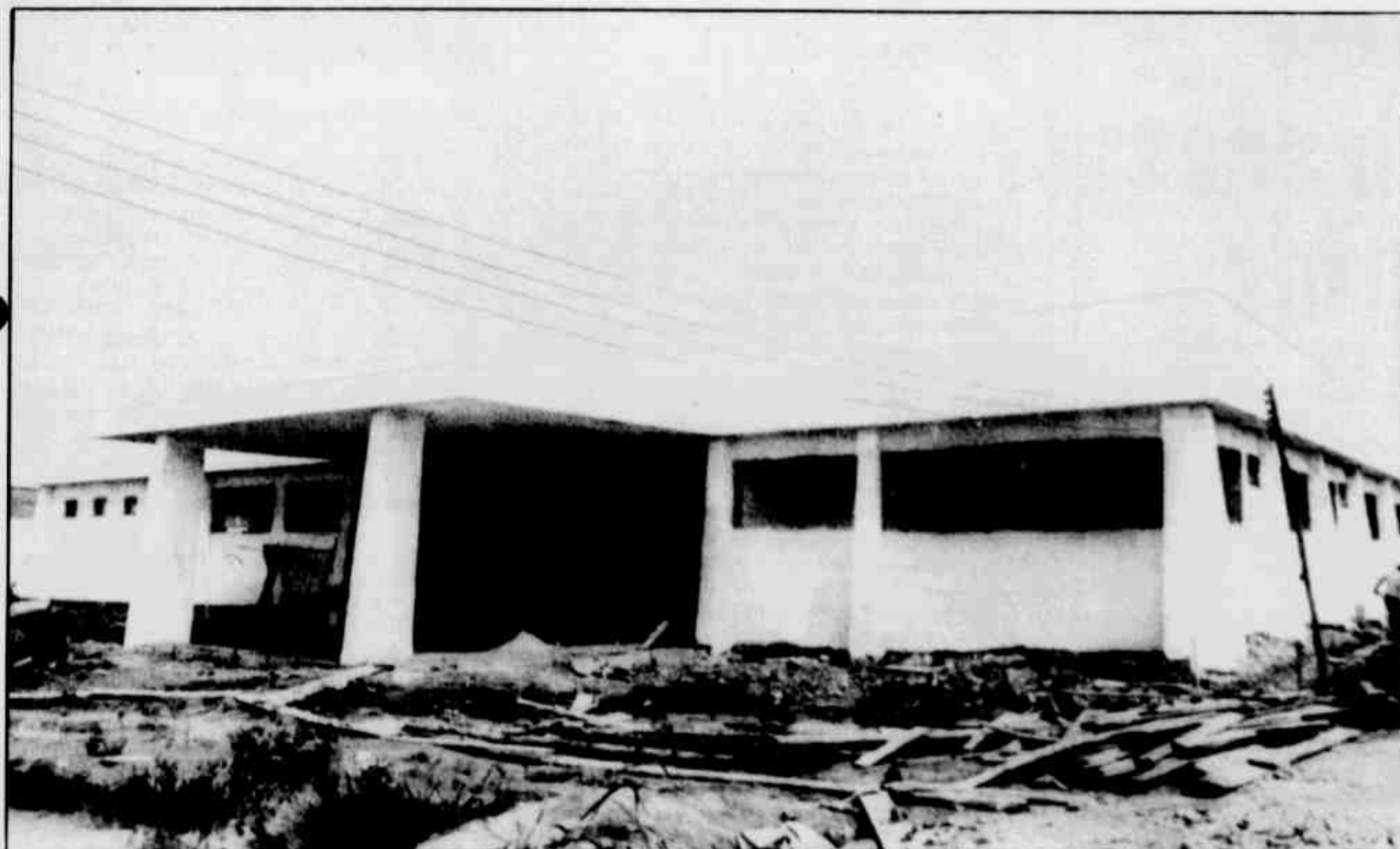
Fachada do novo prédio do JC, em fase de conclusão na Tefé
