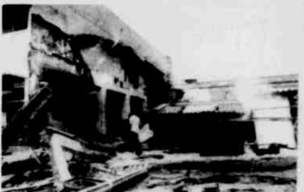
A pesada laje de concreto desabou em cima das mercadorias.
