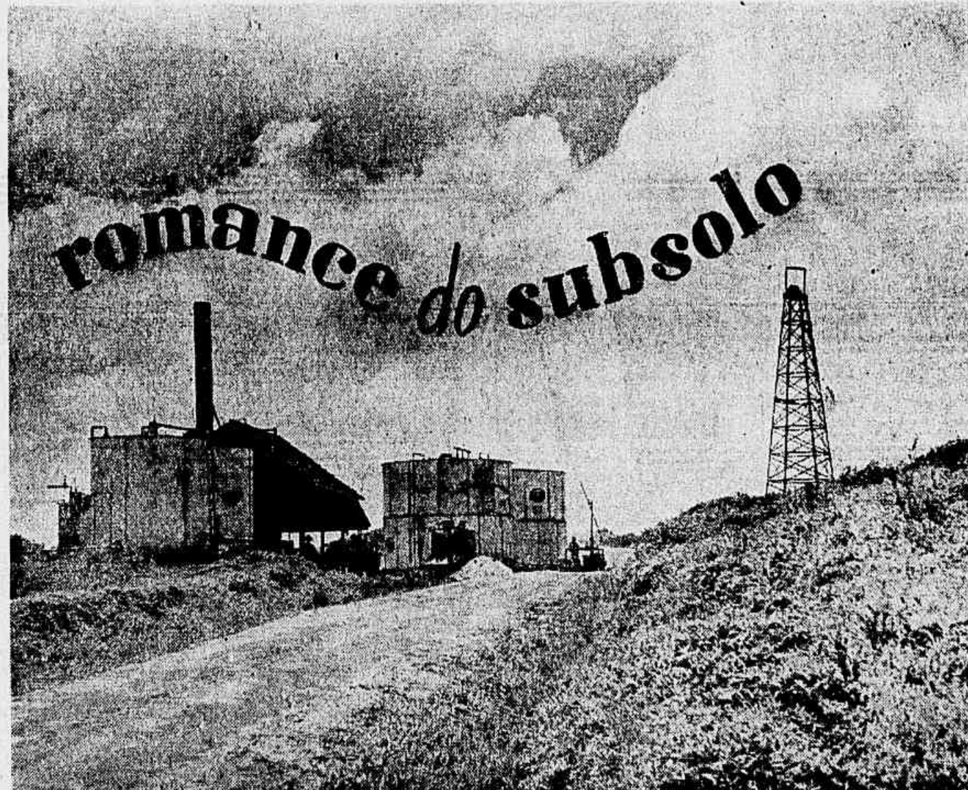
Em Candelas, na Bahia, os depósitos de petróleo multiplicam-se com a força dos novos poços perfurados. A torre, simbolizando a perfuração, e os tanques, dando-nos a certeza da existência do ouro negro, são bem a tranquila e confortadora mensagem de vigor econômico para um país que descobriu a cada instante.
