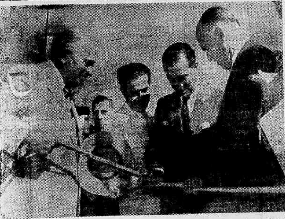
O presidente Juscelino Kubitschek, tendo ao lado o vice-presidente João Goulart, desata a fita simbólica estendida no final da ponte São Luis-Cerro Largo, inaugurando essa importante obra (Foto A.N.)
