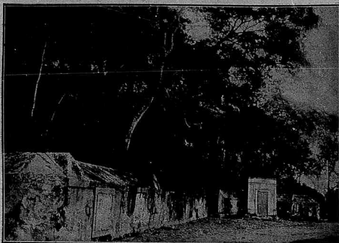
A acequa conductora da agua da Carioca
