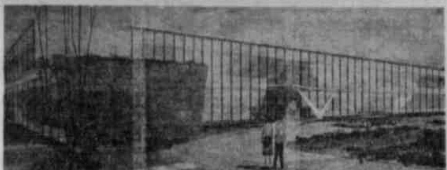
Em vista do que será o futuro Hospital Mário Totta, de Tramandaí, atualmente em fase de construção. O estabelecimento terá uma capacidade para cem leitos, além de todas as dependências e instalações exigidas pela moderna técnica hospitalar.
