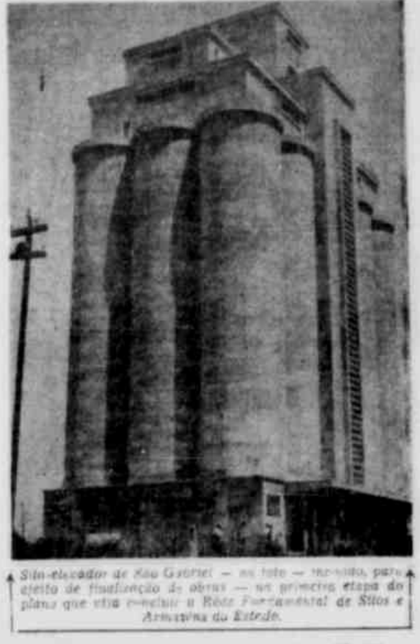
Silo-elevador de São Gabriel — em foto — momento, para efeito de fiscalização de obras — em primeira etapa do plano que visa concluir a Réde Fundamental de Silos e Armazéns do Estado.
