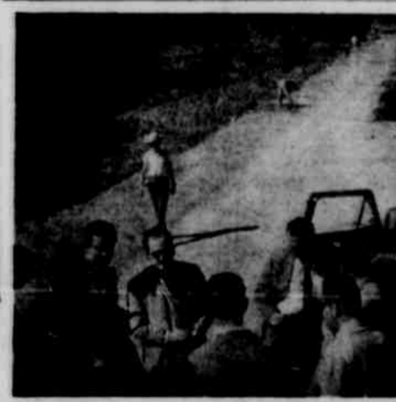
Flagrante apinhado durante a visita que o Secretário dos Transportes, eng.º Daniel Ribeiro, realizou às obras de asfaltamento, no trecho da RS-23, que liga Nova Petrópolis à Canela, na chamada estrada de turismo. Juntamente com o Secretário, viajaram os engenheiros do DAER.
