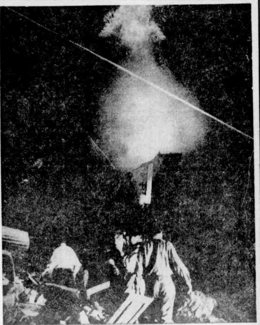
TREMENDO PASSIVO DE UMA TRÁGICA MADRUGADA — A capital do país foi abalada por mais uma tragédia. Um depósito de inflamáveis — 3 mil litros de aguarrás — encoberto pelas chamas de um incêndio que às 3 horas da madrugada de domingo interrompeu num prédio de 8 andares e 48 apartamentos da rua Buenos Aires, 290, de propriedade da firma Corrêa Lima & Cia., que ocupava a loja com uma fábrica de tintas, óleos e vernizes da marca "Mimosas" — explodiu, dando ao sinistro as proporções de uma tragédia. Todo o prédio ruíu, arrastando, na queda dos prédios vizinhos. Os 80 milhões de prejuízos materiais, inclusive um escola "Magirus" (5 milhões) do Corpo de bombeiros não representam o saldo maior da trágica madrugada. O lamentável, o triste, que chocou não apenas a população e tristes e tristes mas quantos brasileiros se interessaram pelo rádio das primeiras notícias da catástrofe, foram as vidas de três bombeiros e de um coadjuvante, feridos pelas chamas, e a quarenta e tantos feridos que procuraram os hospitais e outros tantos que, menos atingidos, não se puderam dos socorros médicos. Um trágico passivo, porém uma nota pungente na madrugada desse 23 de agosto. Na foto, um detalhe do inferno de chamas. (MERIDIONAL).
