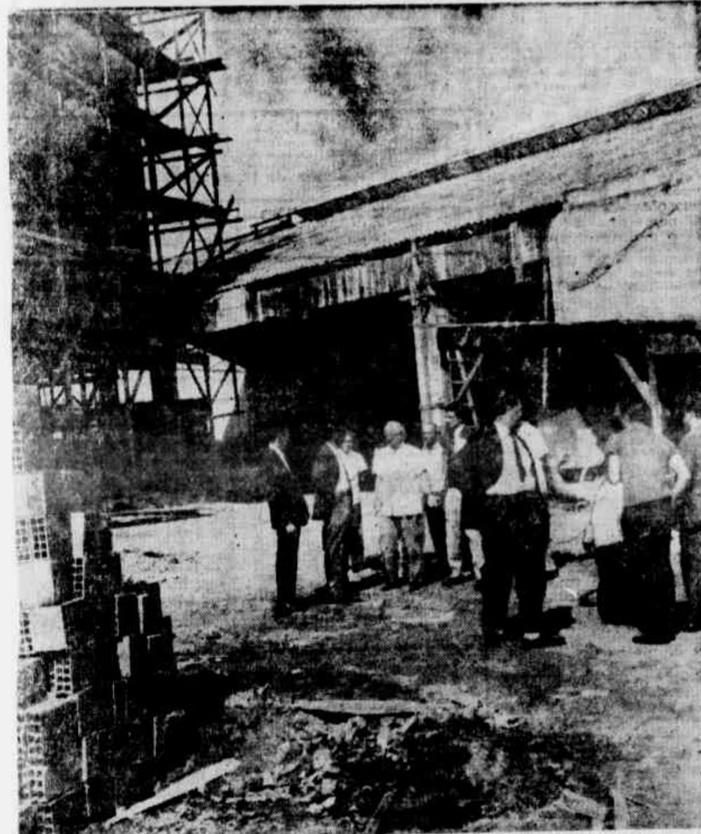
Em companhia dos srs. Váiter Cantermi, chefe do gabinete do presidente da SUSEME e Carlos Cabral, chefe do Departamento de Obras do Estado da Guanabara, o secretário Raimundo de Brito visita as obras do Pavilhão Alfredo Monteiro, no Hospital Getúlio Vargas, cuja inauguração está prevista para março de 1965. Atenderá cerca de 300 mil pessoas da Zona da Leopoldina e também, das cidades fluminenses vizinhas.
