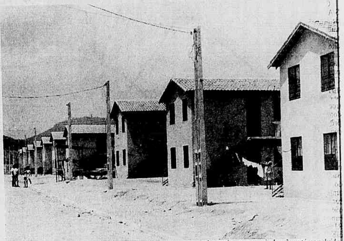
Os invasores continuam ocupando mais de 200 apartamentos do conjunto, que ainda não está concluído
