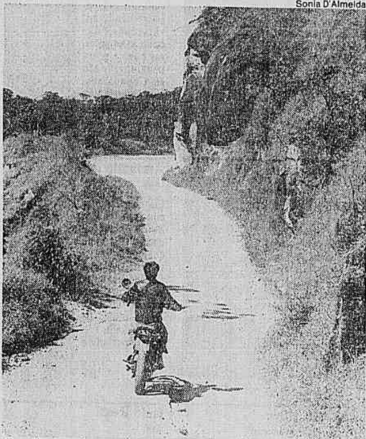
A pavimentação manteria o traçado original da Parati-Cunha
