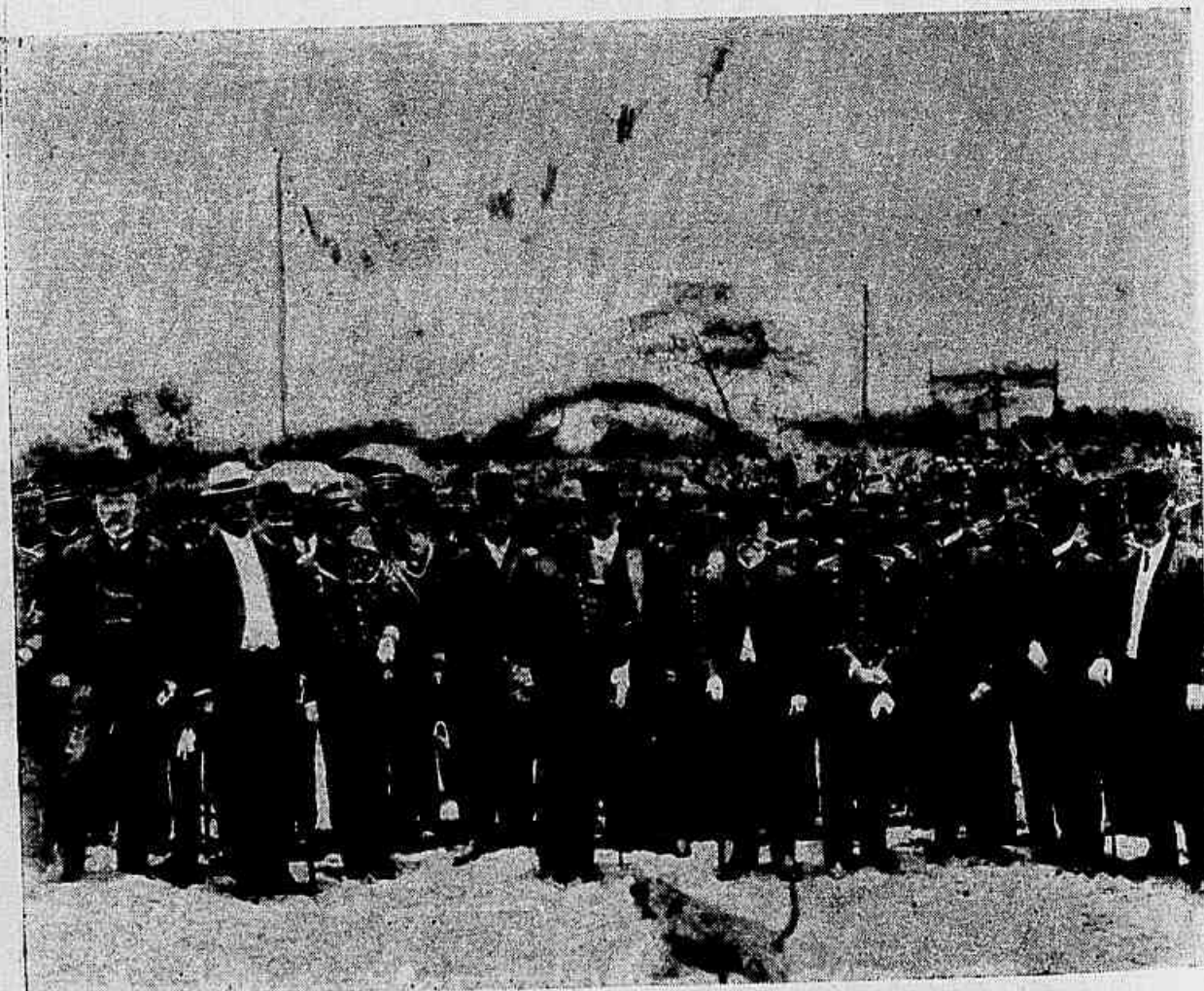
Grupo tirado na nova plataforma, depois do assentamento da pedra
